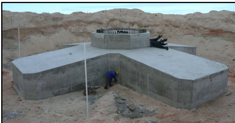
Figura 2.5 – Plataforma de Fixação das Torres dos Aerogeradores
