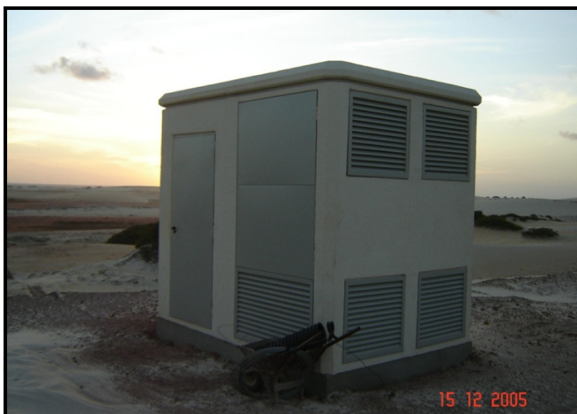
Figura 2.8 – Exemplo de uma Subestação Unitária Abrigada COMPLEXO EÓLICO FAISA – TRAIRI / CE
